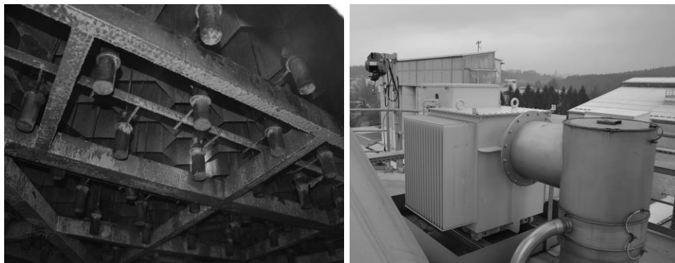
Slika 83: Mokri elektrostatični filter, levo: notranjost, pogled skozi odprtino nad pralnikom in pod elektrostatičnim filtrom. Uteži napenjajo negativne elektrode. Desno: visokonapetostni transformator in usmernik, pred njim je izolator s cevjo za ogrevanje in sušenje izolatorjev.
