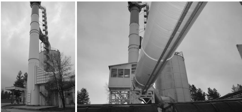
Slika 79: Levo: dimnik in za njim pralnik WESP in elektrostatični filter za odstranjevanje delcev iz plinov iz usedalne komore, trdilne komore in hladilne cone. Desno: dovod v čistilno napravo, cevovod za umazane pline in dve cevi za čisto vodo in za umazano vodo, ki služi kot absorpcijsko sredstvo.
