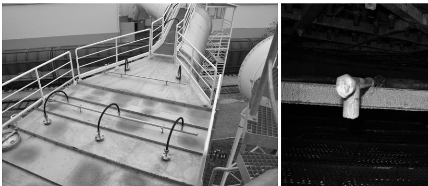
Slika 81: Mokri elektrostatični filter. Levo: dovodni cevovod, na vrhu dovodnega cevovoda so pralniki s šobami za pršenje vode za odstranjevanje delcev, zniževanje temperature in požarno varnost. Desno: šoba absorpcijskega sredstva, ki je nameščena nad pralnikom. Pod pralnikom je še ena vrsta šob, ki pršijo navzgor. V pralniku so polnila iz naluknjane in zakrivljene pločevine.
