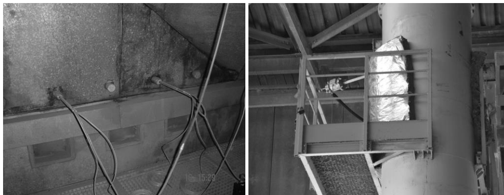
Slika 46: Vzorčevanje dimnih plinov, levo: odjemi dimnih plinov na steni, kovinski priključki, ki se nadaljujejo v silikonske cevke služijo odjemu dimnih plinov. Električni kabli so za merjenje temperature. Desno: odjemno mesto na dimniku za vzorčevanje delcev ali plinov z izokinetično metodo.
