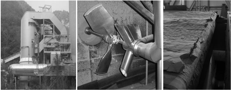
Slika 85: Čistilna naprava Termoelektrarne Trbovlje, levo: zgradba [www.rudis.si], v sredini: mešalo in aerator, desno: posušena sadra kot končni produkt razžveplanja
