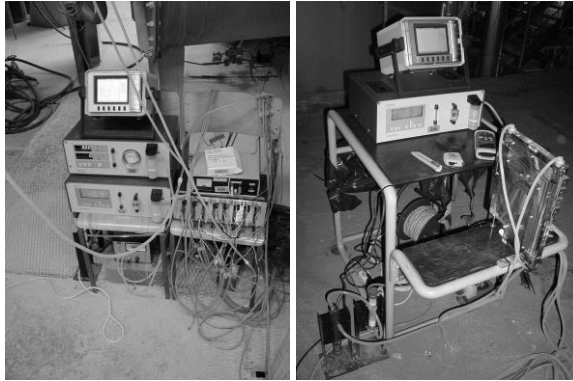
Slika 51: Analizatorji za merjenje koncentracij dimnih plinov, levo: na levi strani so od zgoraj navzdol data logger, 2 x IR-analizatorja Siemens Ultramat 22 in Siemens Ultramat 23, povsem spodaj analizator koncentracije kisika. Desno od analizatorja koncentracije kisika je dodatna membranska črpalka. Na desni strani slike je napajalnik in priključna plošča za data logger. Desno: od zgoraj navzdol data logger in IR-analizator Siemens Ultramat 23, spredaj merilnik tlaka s poševno cevko U. Spodaj levo je priprava za izločanje kondenzata (temni lonček z zamaškom na spodnji strani) in filtriranje ter razvlaževanje (lonček z vato/silikagelom/vato in zamaškom na zgornji strani). Spodaj pod mizico je dodatna membranska črpalka za hitrejšo odzivnost sistema.
