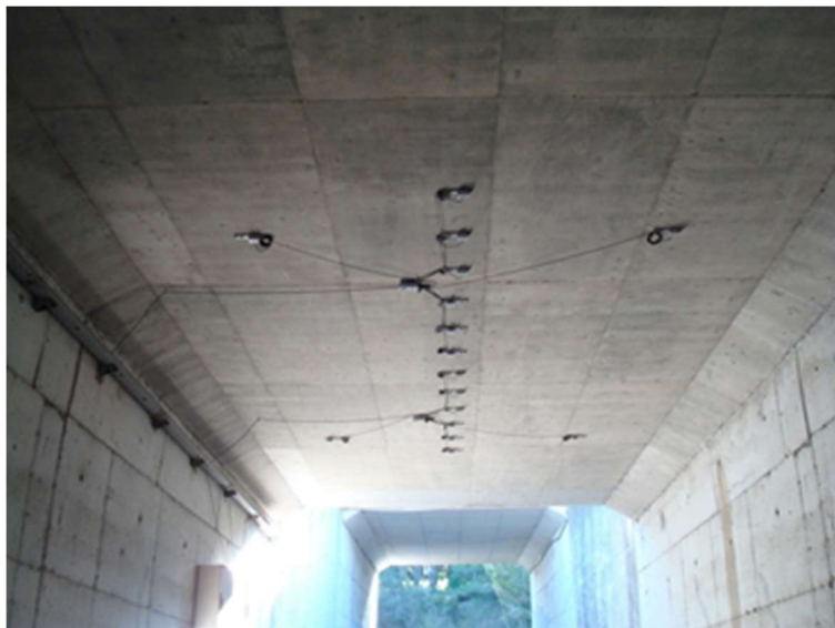
Slika 82: Namestitev zaznaval na spodnji strani nosilca mostu (slika: © Cestel/SiWIM)
