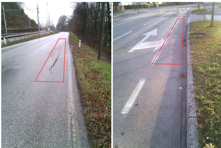
Slika 78: Poškodbe vozišča zaradi pretežkih vozil (levo razpoka, desno vdolbina)
