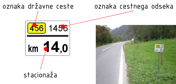
Slika 19: Označevalna tablica na državnih cestah
