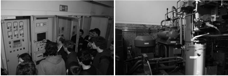
Slika 72: Krmiljenje HE Medvode; levo: digitalni turbinski krmilnik na HE Medvode; desno: krmilnik nadzoruje delovanje hidravličnega agregata za premikanje vodilnih in gonilnih lopatic Kaplanove turbine [obe sliki z dovoljenjem: SEL d.o.o.]
