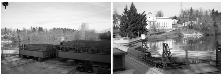
Slika 61: Zapornice turbinskega vtoka na HE Medvode; levo: zložene zapornice; desno: mesto za vstavljanje zapornic v pretočni trakt vodne elektrarne [z dovoljenjem: SEL d.o.o.]
