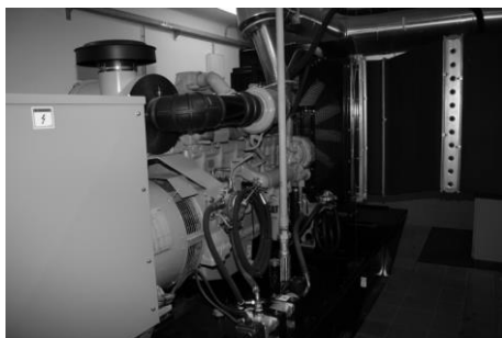
Slika 75. Dizelski agregat v HE Medvode, [z dovoljenjem: SEL d.o.o.].
