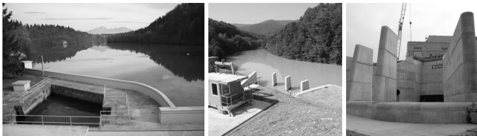
Slika 54: Zobje in rešetke na vodnih elektrarnah; levo: zob HE Medvode in rešetka, zob zadržuje plavje, rešetka pa ni vidna, nahaja se pod kovinsko ograjo na spodnjem delu slike. Zaradi zoba je vtočni kanal približno 3 m pod gladino in nekaj m nad tlemi. S tem se zmanjša možnost, da bi v elektrarno tok vode prinesel večje kose lesa. V sredini in desno: vtočno iztočni objekt v ČHE Avče med delovanjem in med gradnjo. Zobje pri ČHE Avče so navpični in nameščeni tako, da preprečujejo, da bi v elektrarno posrkalo večje plavajoče kose lesa, [z dovoljenjem: SEL d.o.o. in SENG d.o.o.].
