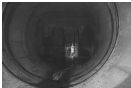
Slika 60: Nameščene zapornice turbinskega iztoka na cevni turbini HE Dubrava, Hrvaška.
