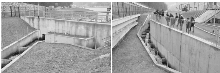
Slika 79: Ribja steza He Krško, posamezni bazeni vsebujejo predele z sorazmerno mirno vodo, kjer se ribe lahko spočijejo [z dovoljenjem: Hidroelektrarne na Spodnji Savi, d.o.o.].
