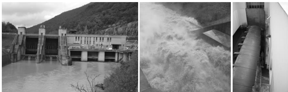
Slika 77: Prelivna polja na pretočnih elektrarnah, levo: HE Solkan z dvema prelivnima poljema in tremi turbinskimi polji [z dovoljenjem: SENG d.o.o.]; v sredini: prelivni polji HE Solkan med poplavami leta 2012 [z dovoljenjem: SENG d.o.o.]; desno: tablasta zapornica kljukaste izvedbe na prelivnem polju HE Medvode [z dovoljenjem: SEL d.o.o.]
