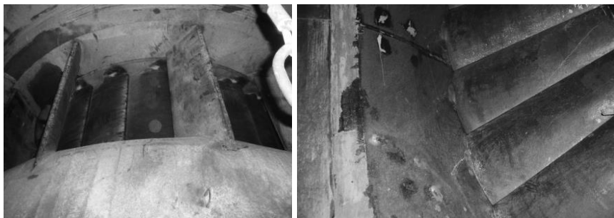
Slika 63: Predvodilne in vodilne lopatice vodnih turbin; levo: vodilne in predvodilne lopatice na HE Solkan (Kaplanova turbina) [z dovoljenjem: SENG d.o.o.]; desno: vodilne lopatice na cevni turbini HE Dubrava, Hrvaška
