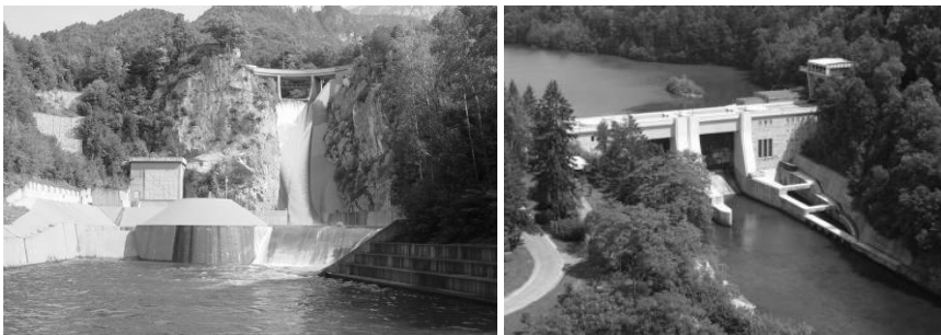
Slika 53: Jezovi hidroelektrarn; levo: betonski ločni jez HE Moste je najvišji jez v Sloveniji; desno: jezovna zgradba HE Medvode kombinirano stebarsko-obrežnega tipa, zadaj akumulacija Zbiljsko jezero [z dovoljenjem: SEL d.o.o.].
