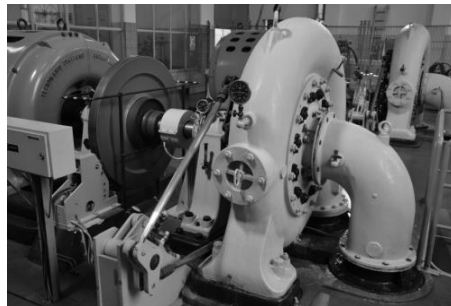
Slika 69: Ležaji na manjših elektrarnah so preprostejši, v primeru HE Hubelj so ležaji drsni. Ležaj je svetel del na gredi med generatorjem in turbine. Na sliki je viden ob generatorju tudi vztrajnik (angl. flywheel), ki služi za primer otočnega delovanja, če je elektrarna s porabniki ločena od ostalega električnega omrežja [z dovoljenjem: SENG d.o.o.]
