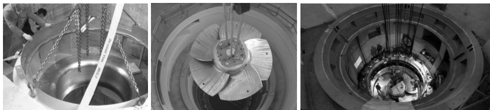
Slika 36: Vgradnja Kaplanove turbine [z dovoljenjem: Siapro d.o.o., www.siapro.eu (levo) in SEL d.o.o. (desno in v sredini)]
