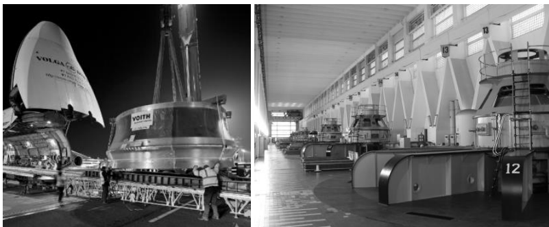
Slika 11: HE Bratsk, Rusija, 18x250 MW, največja elektrarna, kjer je prevzemne terenske meritve izvedlo podjetje iz Slovenije, Kolektor Turboinštitut d.o.o. Levo: transport gonilnika, [vir: http://www.hydropworld.com ]. Desno: strojnica vodne elektrarne Bratsk [z dovoljenjem: Kolektor Turboinštitut d.o.o.].
