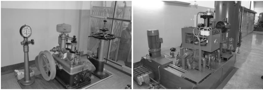
Slika 71: Krmiljenje kota vodilnih in gonilnih lopatic; evo: stari hidravlični krmilnik odprtja vodilnika na HE Hubelj, ki ni več v uporabi; desno: hidravlični agregat z mehanskim krmilnikom vrtilne frekvence na HE Solkan [obe sliki z dovoljenjem: SENG d.o.o.]
