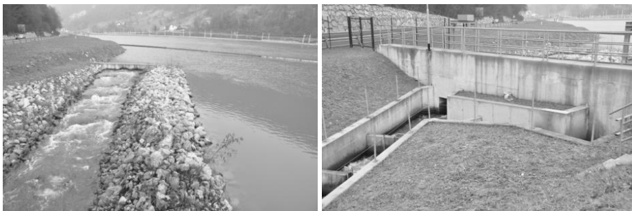
Slika 78: Ribja steza HE Krško; levo: gorvodna povezava s Savo, desno: ribe prehajajo v ribjo stezo zgolj na določeni višini, zato je potrebno izvesti več vstopov po višini. Posamezni vstopni kanali se združijo v enotno ribjo stezo. V primeru HE Krško sta izvedena dva vstopa [z dovoljenjem: Hidroelektrarne na Spodnji Savi, d.o.o.].
