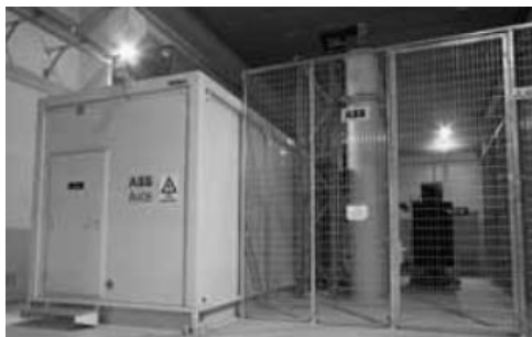
Slika 73: Vzbujevalni sistem v ČHE Avče; levo v kontejnerju je kontrolni del, hladilni del in močnostni del, desno pa vzbujevalni transformator [z dovoljenjem: SENG d.o.o.].
