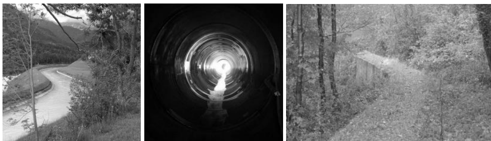
Slika 56: Dovodni kanali in tuneli za dovod vode v turbino vodne elektrarne; levo: dovodni kanal HE Oberrach, Nemčija; v sredini: notranjost dovodnega tunela ČHE Avče [z dovoljenjem SENG d.o.o.]; desno, betonski dovodni tunel HE Hubelj [z dovoljenjem SENG d.o.o.]
