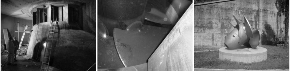
Slika 14: Kaplanova turbina; levo: spirala Kaplanove turbine med servisiranjem, HE Solkan; v sredini: pogled na gonilnik iz vodilnika, HE Solkan; desno: stari gonilnik HE Plave I, vidna so vrtilišča lopatic [vse z dovoljenjem: SENG d.o.o.]
