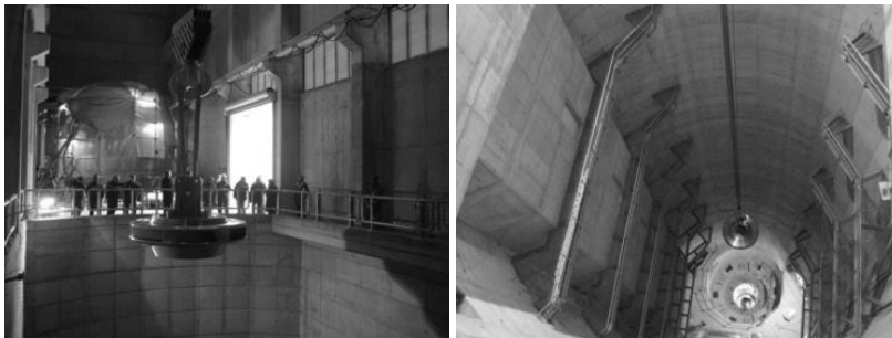
Slika 12: Vgradnja ČHE Avče, spust gonilnika v jašek strojnice [z dovoljenjem: SENG d.o.o.]
