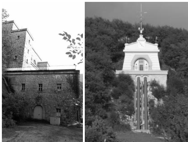
Slika 57: Vodostan; levo: vodostan prečrpovalne elektrarne Walchensee v Nemčiji; desno: vodostan HE Završnica
