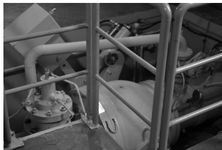
Slika 45: Razbremenilni varnostni ventil na HE Hubelj; prikazan je na sliki levo spodaj [z dovoljenjem: SENG d.o.o.].
