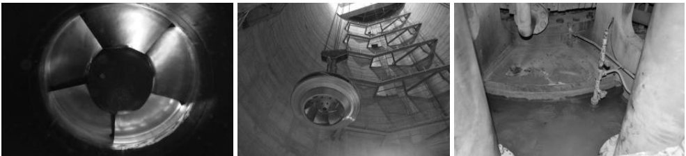
Slika 65: Gonilniki vodnih turbin; levo: gonilnik Kaplanove turbine, pogled s spodnje strani iz sesalnega stožca (HE Doblar I); v sredini: spust gonilnika, vidne so luknje v gonilniku za vpihovanje zraka, ČHE Avče; desno: pokrov gonilnika ČHE Avče [vse z dovoljenjem: SENG d.o.o.]
