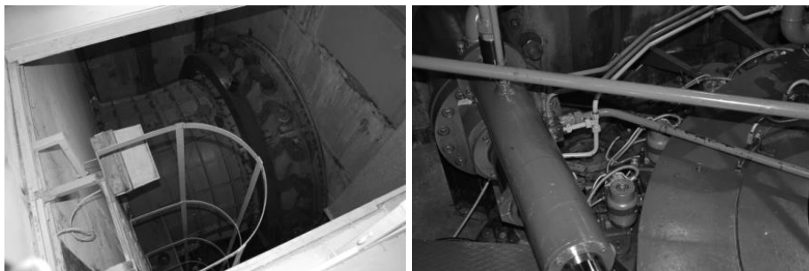
Slika 64: Vodilni obroč; levo: vodilni obroč na cevni turbini HE Dubrava, Hrvaška; desno: vodilni obroč na Kaplanovi turbini HE Solkan, vidna je hidravlična roka za premikanje vodilnika in mehko vpete lopatice z mikrostikali [z dovoljenjem: SENG d.o.o.]
