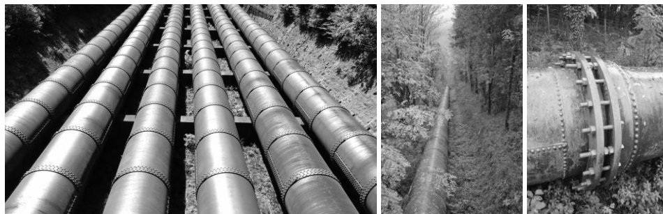
Slika 58: Tlačni cevovod vodi vodo iz zgornje akumulacije na vodno turbino; levo: tlačni cevovod ČHE Wachensee, Nemčija; v sredini: tlačni cevovod HE Hubelj; desno: tlačni cevovod HE Hubelj, spojka in dilatacija na njem [z dovoljenjem: SENG d.o.o.]
